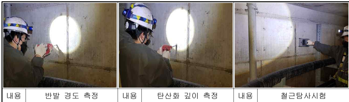
【사진 5.17】 신덕은문산 재료시험 전경
